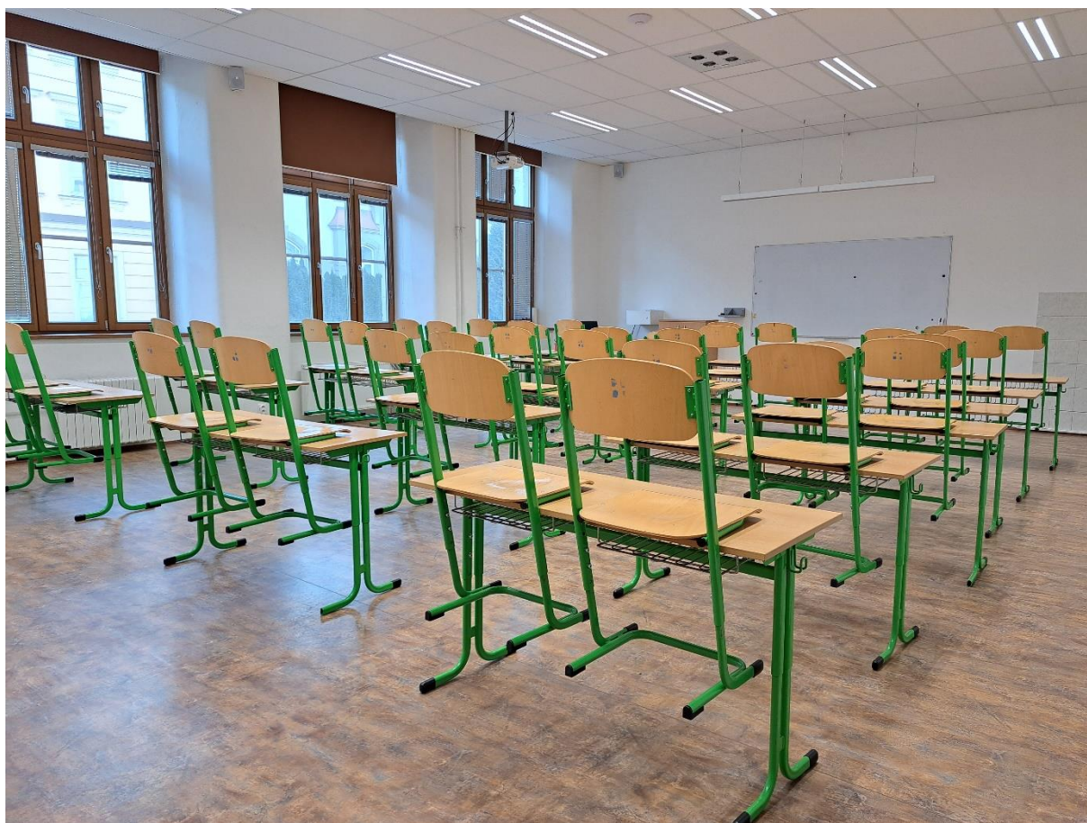
Obrázek 4 – výměna podlahy ve třídě
