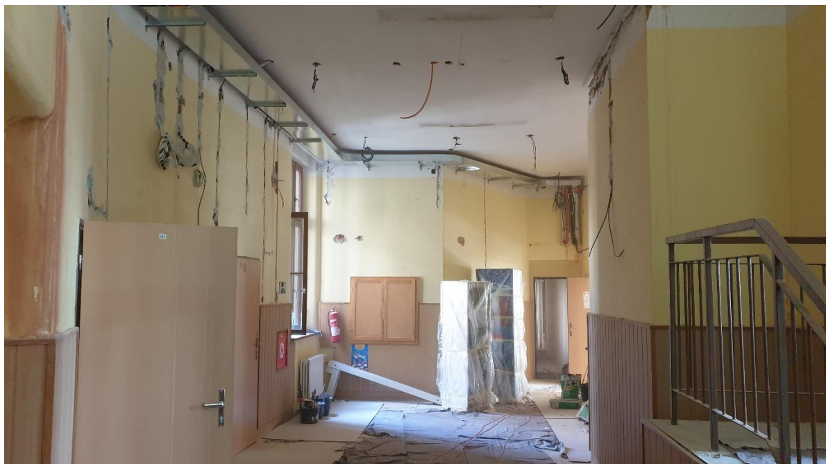
Obrázek 2 – rekonstrukce elektroinstalace
